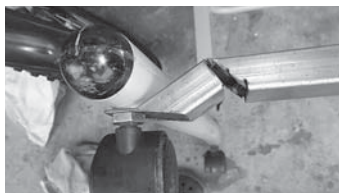
④穴と高さを調整した後、角度が決 まったところで溶接。
